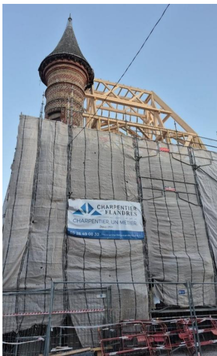
Figure 54 : Imprimerie Landais actuellement en cours de travaux (Pouilly, O, Avril 2026)
