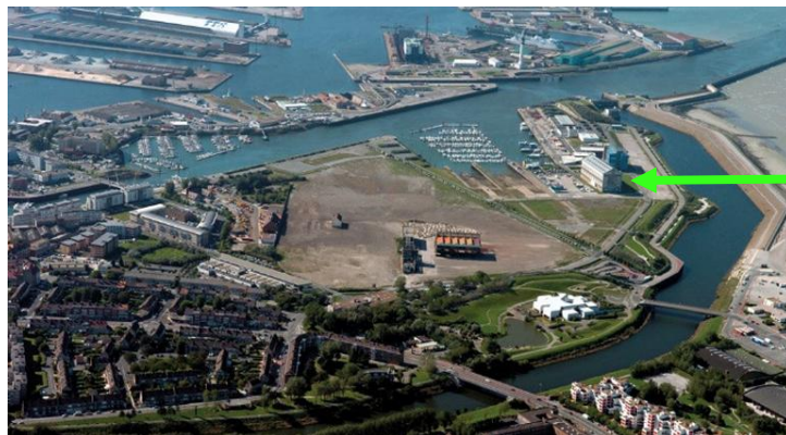
Figure 94 : Images aériennes après la fermeture des chantiers de France (CMUA - Archives de Dunkerque, s. d.-b)
