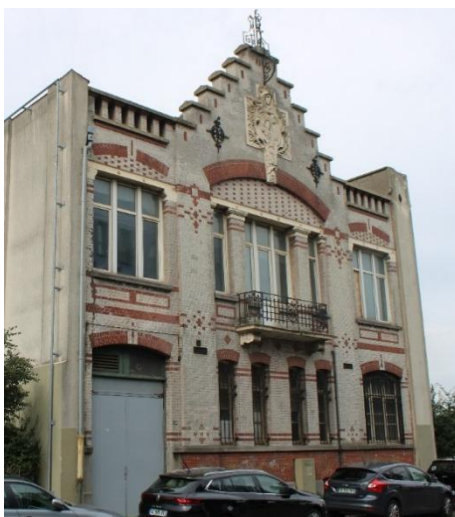
Figure 86 : Bâtiment Coquelle-Gourdin (Pouilly, O, 2025)
