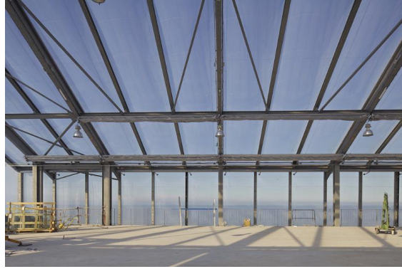
Figure 101 : Coussin en ETFE présent aux deux derniers étages (lacaton & vassal, s. d.)
