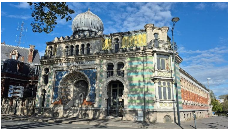
Figure 115 : Photo de la façade principale – rue de l'écluse de Bergues (Pouilly, O, 2026)
