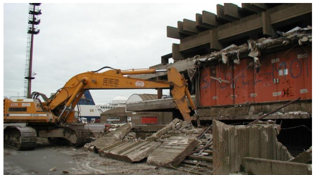
Figure 53 : BCMO durant sa destruction en 2004 (Lefebvre, 2023)
