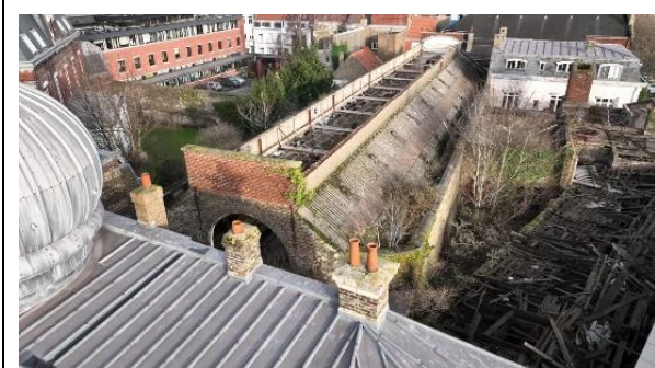
Figure 123 : Photo des bains vue du dessus en 2024 (CorsaireTV, 2024)
