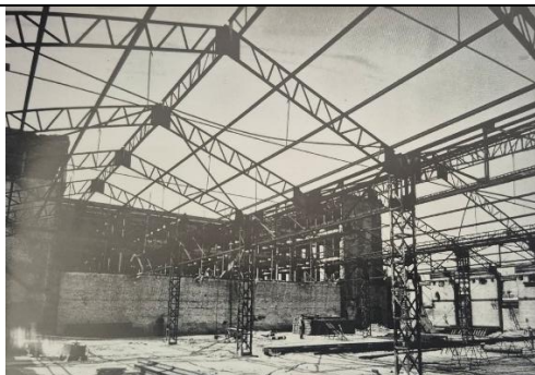
Figure 68 : Premier entrepôt après les bombardements de la guerre, reconstruction de la charpente métallique (CMUA - Archives de Dunkerque & Ville de Dunkerque, 2014)
