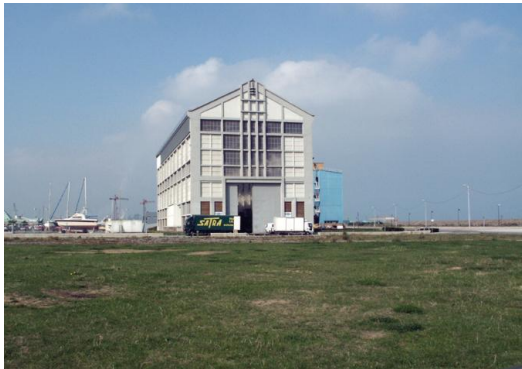
Figure 97 : La Halle AP2 (lacaton & vassal, s. d.)
