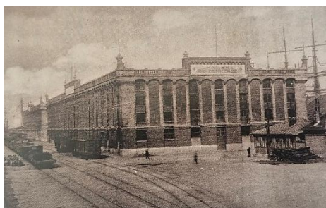
Figure 65 : Vue des deux entrepôts (CMUA - Archives de Dunkerque & Ville de Dunkerque, 2014)
