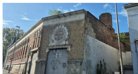
Figure 117 : Photo façade - rue du quai au Bois (Pouilly, O, 2026)
