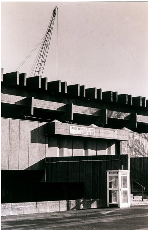
Figure 51 : BCMO en Février 2004 avant sa destruction (Bernard Cartiaux, 2004)
