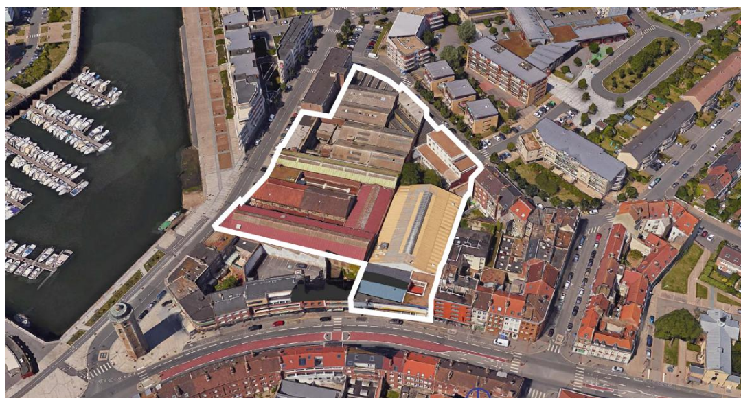
Figure 79 : Etat du site avant démolition en 2004 (SPAD, 2020)
