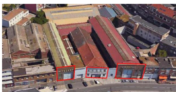
Façades du bâtiment Nicodème Quai des Américains à conserver Figure 80 : Façade du site à conserver (SPAD, 2020)
