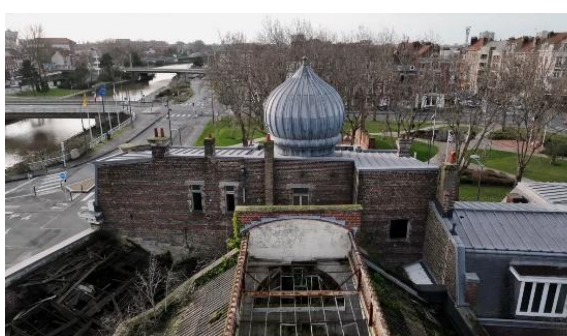
Figure 124 : Photo des bains vue du dessus en 2024 (CorsaireTV, 2024)
