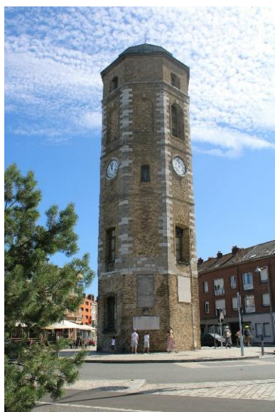
Figure 59 : Tour du Leughenaer (Pouilly, O, 2024)
