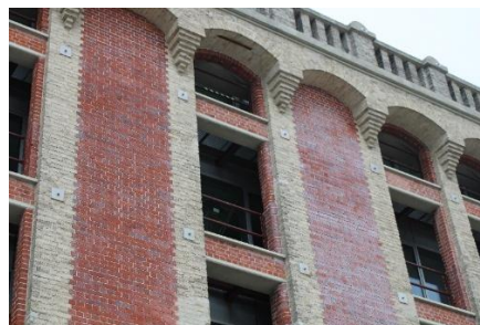
Figure 76 : Halles aux sucres – vue en façade
