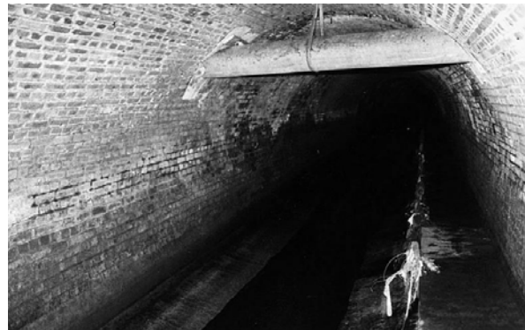
Fig.31 Intérieur d'un canal © La voix du Nord
