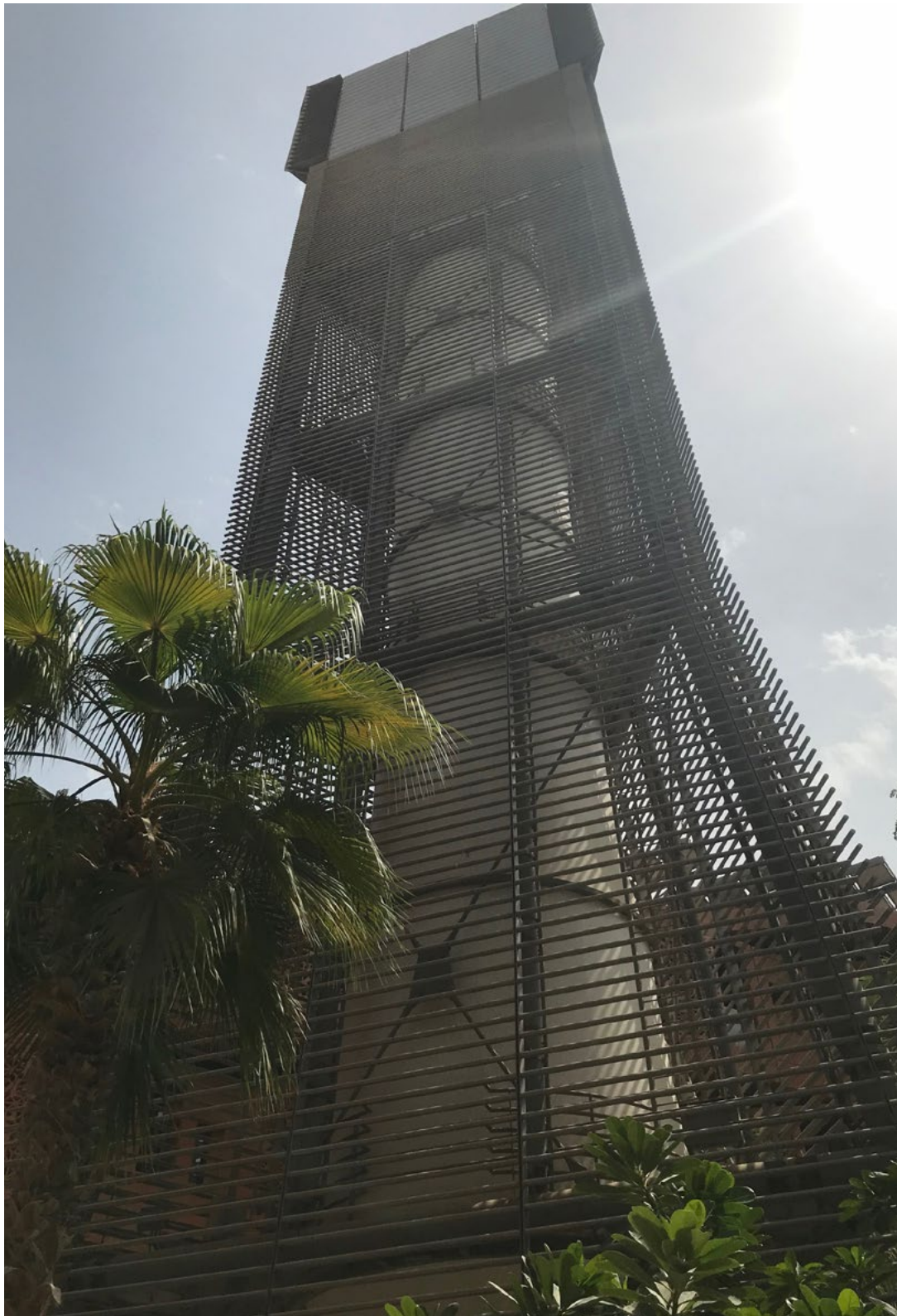
61 Tour à vent à MAS- DAR City, Emirats Arabes Unis.
