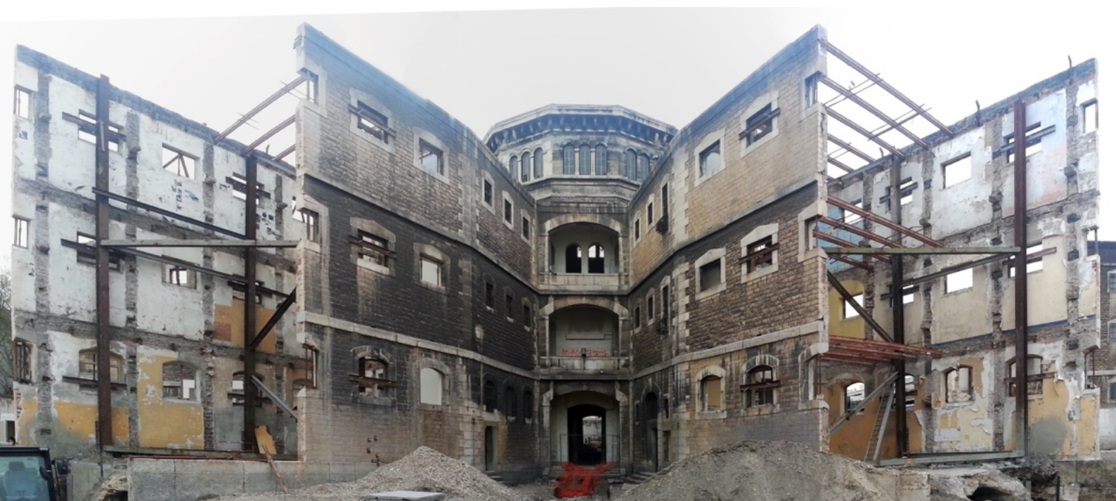
Figure 23 : Ancienne prison Saint-Paul à Lyon pendant la transformation.
