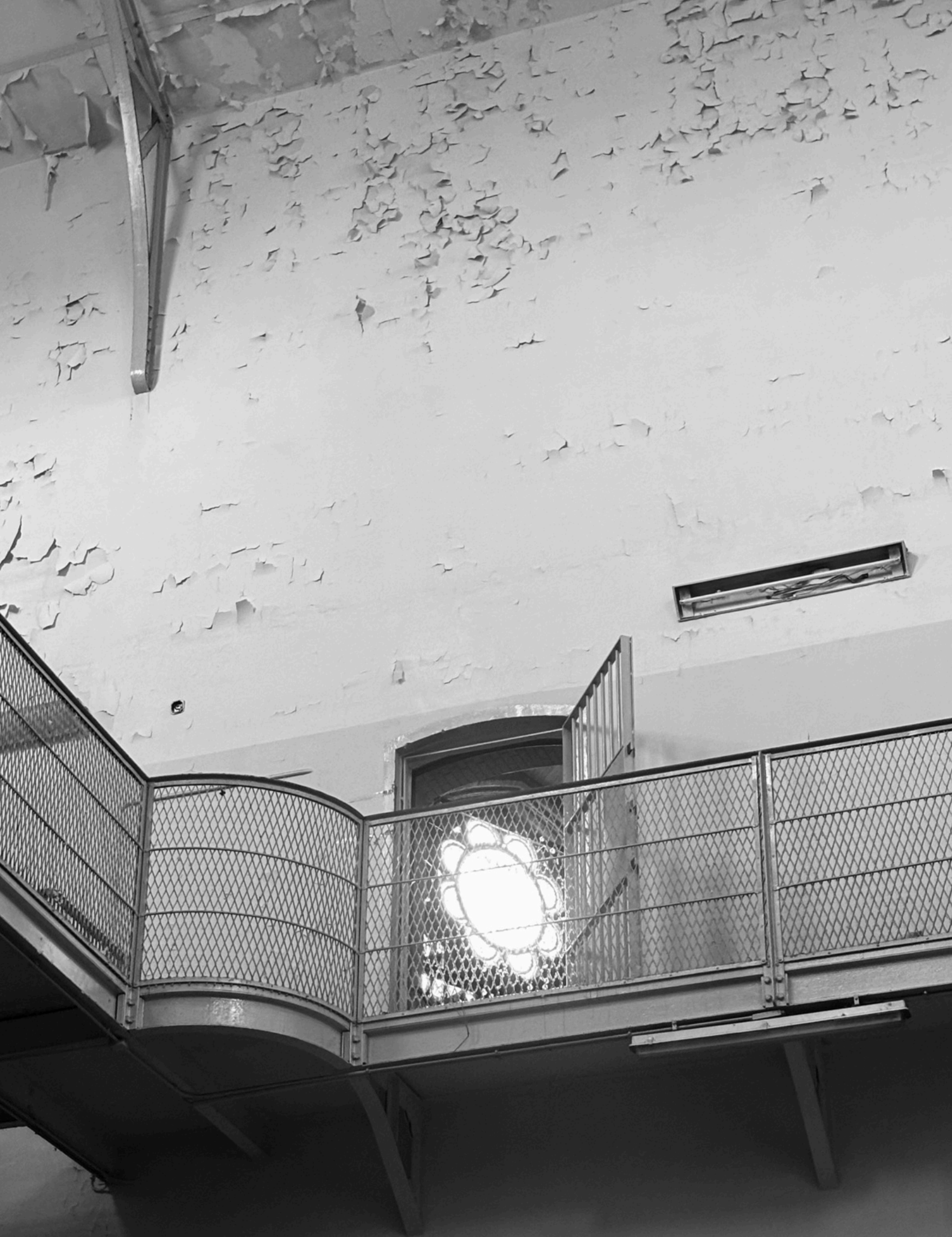
Figure 77 : Perspective sur les vitraux de la chapelle depuis le centre des ailes A et B
