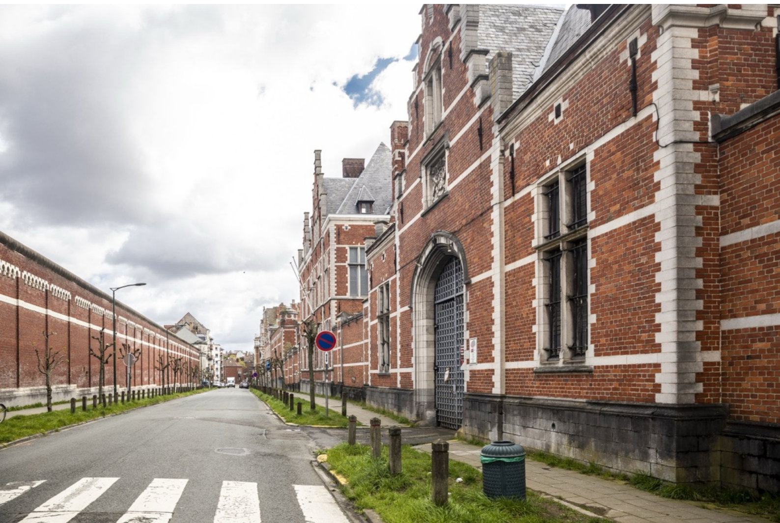
Figure 71 : Avenue de la Jonction (Saint-Gilles à gauche, Forest à droite)
