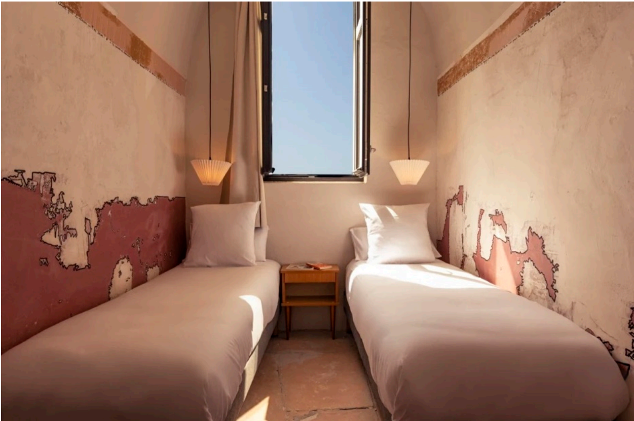
Figure 33 : Chambre de l'hôtel La Prison à Béziers. Le projet conserve volontairement certaines traces de l'ancienne prison comme les proportions de la cellule ou les murs dégradés afin de maintenir une lecture du passé carcéral du lieu.
