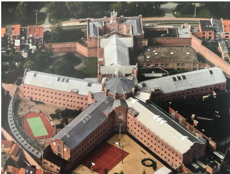
Figure 17 : Vue aérienne de la prison de Gand illustrant l'organisation radiale du complexe carcéral autour d'un noyau central.
