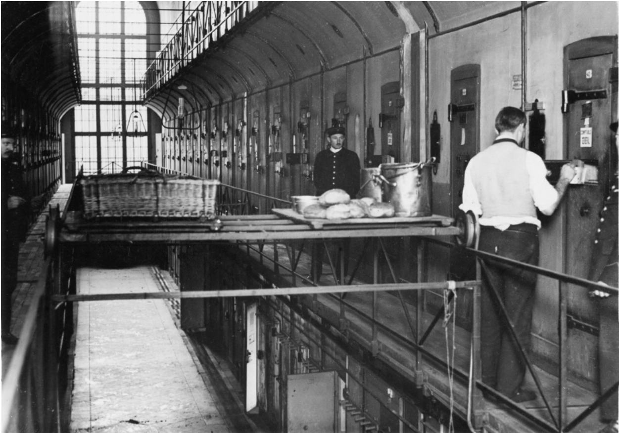
Figure 59 : Coursives métalliques et dispositif de distribution de nourriture dans la prison de la Santé à Paris, vers 1929-1931. Cette photographie met en évidence la verticalité des ailes cellulaires, la répétition des cellules, l'étroitesse des circulations et le rôle central des coursives métalliques dans l'organisation spatiale et la surveillance des prisons radiales et cellulaires.
