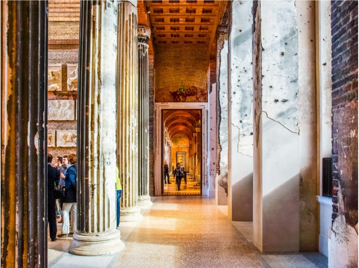
Figure 29 : Traces anciennes conservées et intégrées dans la rénovation du Neues Museum à Berlin
