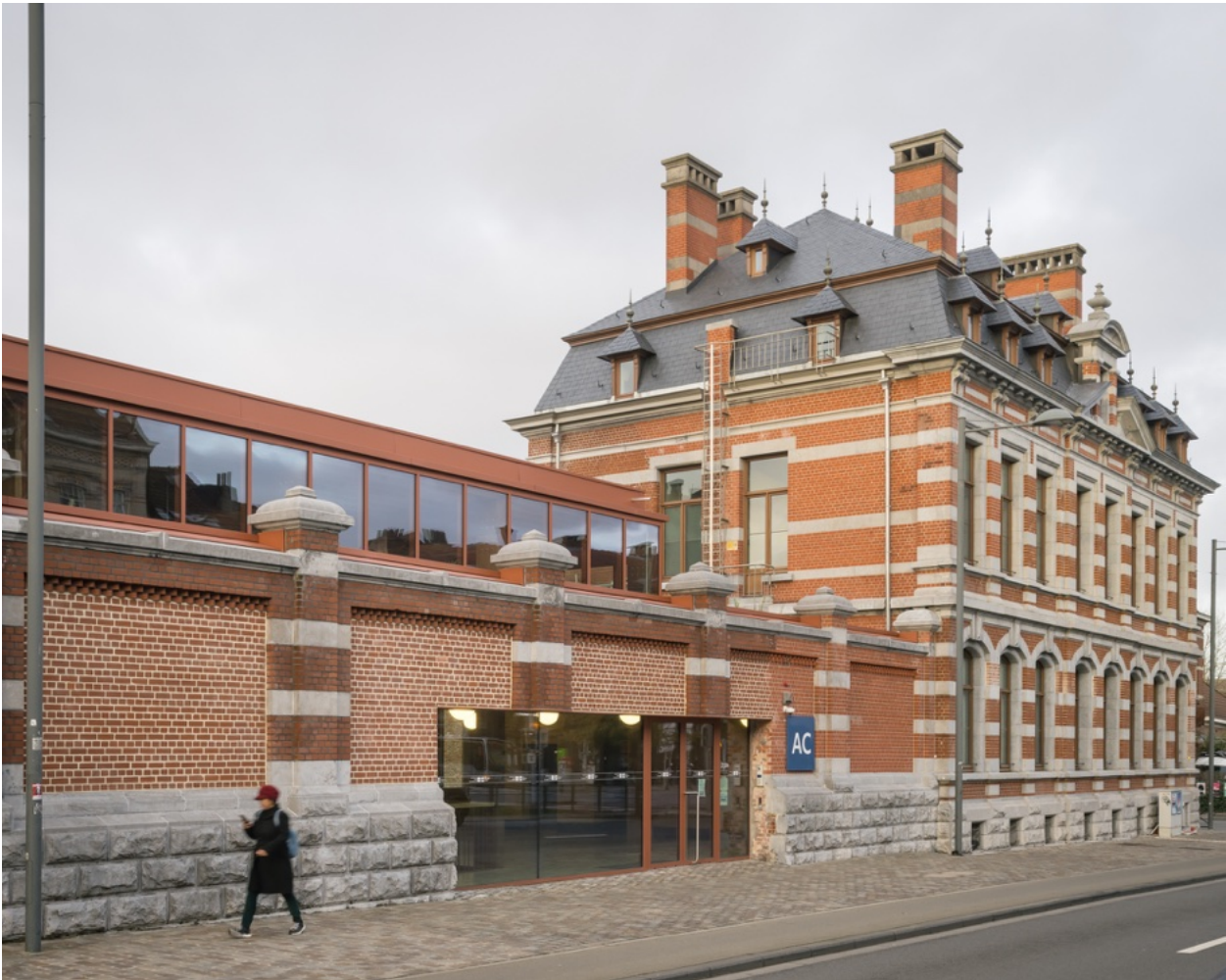
Figure 31 : Transformation du mur d'enceinte et ouverture du site du projet Usquare Brussels, issu de la reconversion de l'ancienne caserne de la gendarmerie à Bruxelles.
