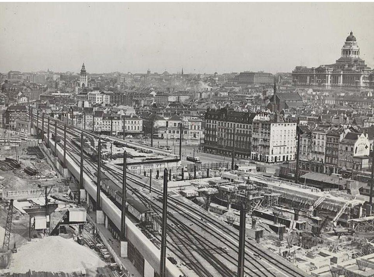
Figure 60 : Le chantier à hauteur de la gare du Midi et du viaduc sud
