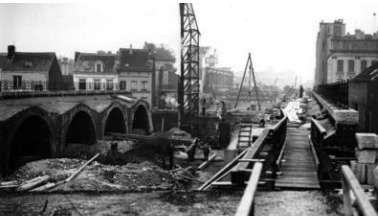
Figure 61 : Le chantier du viaduc sud
