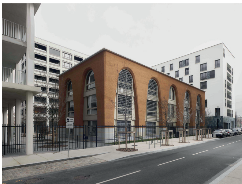
Vue de la façade du bâtiment de bureaux de l'Orangerie Réversibilité technique, Ydeal Confluence, Lyon, 2015
