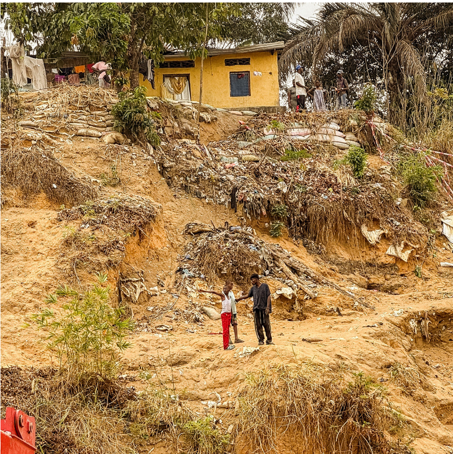
Glissement de terrain
