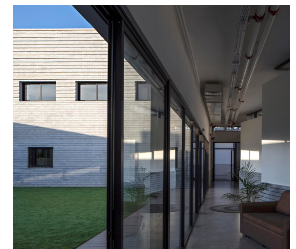
Fig 60 : Façade extérieure. © Amit Geron
